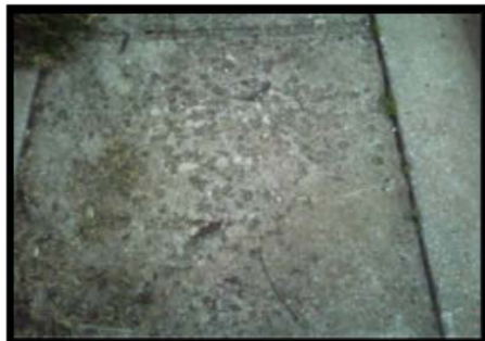
Spalling
